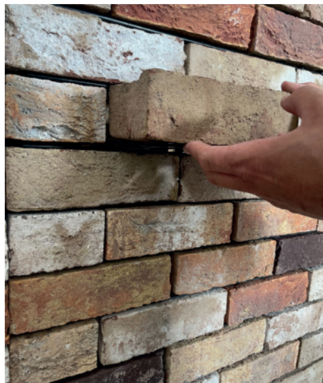
Plaats een schuin afgezaagde steen terug in de muur
