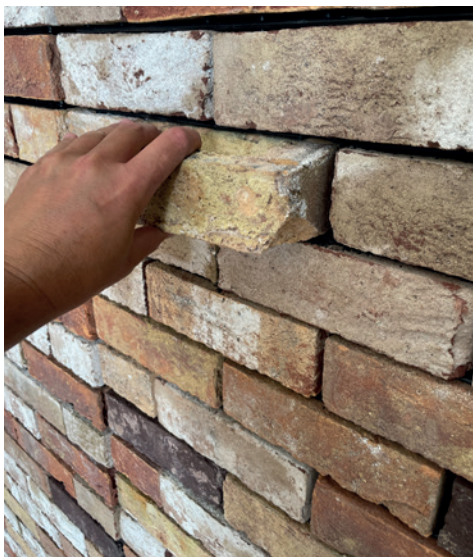
Haal de steen uit de gevel
