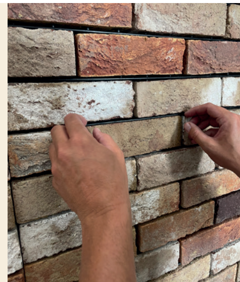
Plaats een geknipte layer terug op de lintvoeg.
