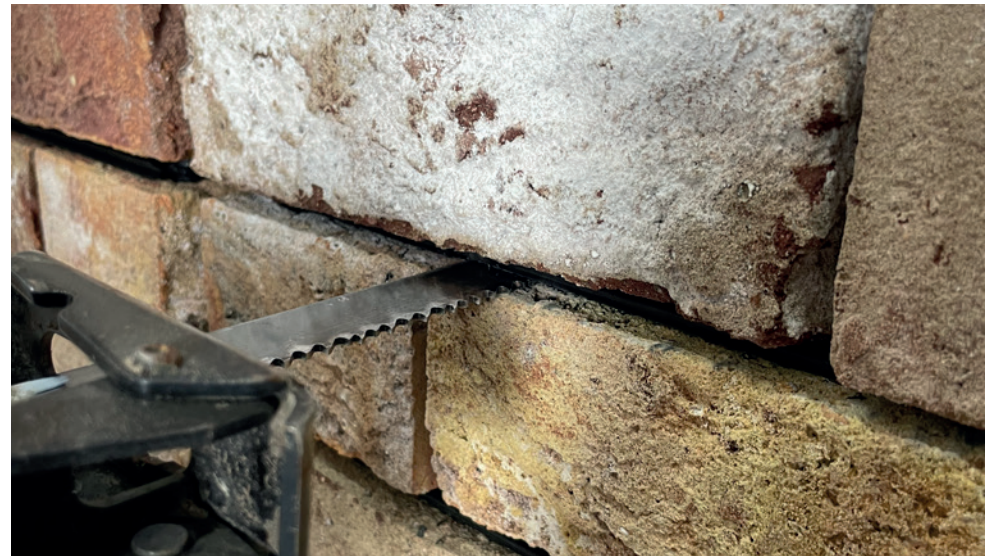
Zaag layer rondom door bij zijn nopjes
