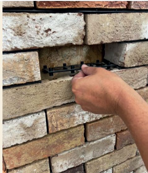
Plaats aan de onderkant een nieuw geknipte layer
