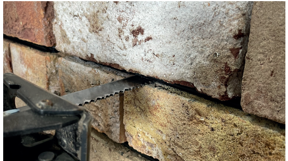
Zaag layer rondom door bij zijn nopjes
