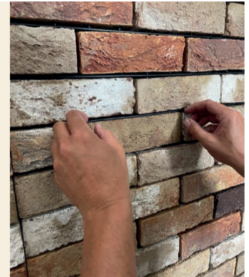
Plaats een geknipte layer terug op de lintvoeg.
