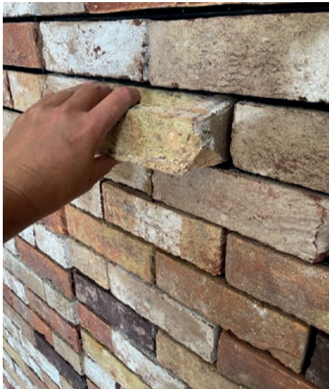
Haal de steen uit de gevel
